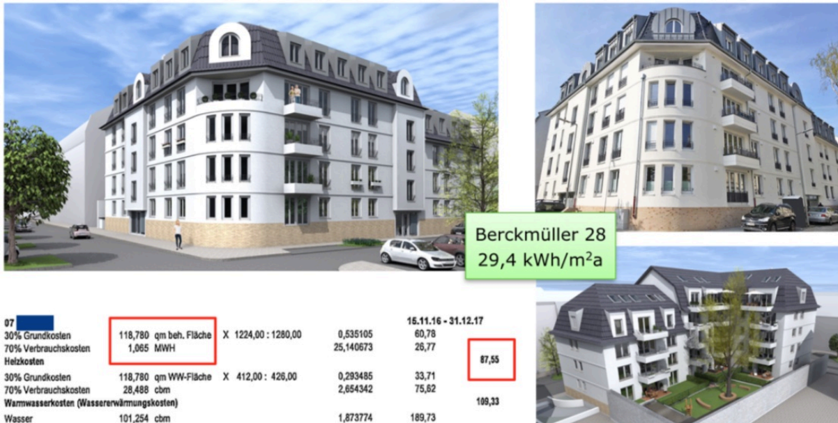
Stadthaus Berckmüllerstraße Karlsruhe mit 21 Wohneinheiten
